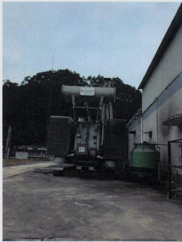
项目南面-山地
