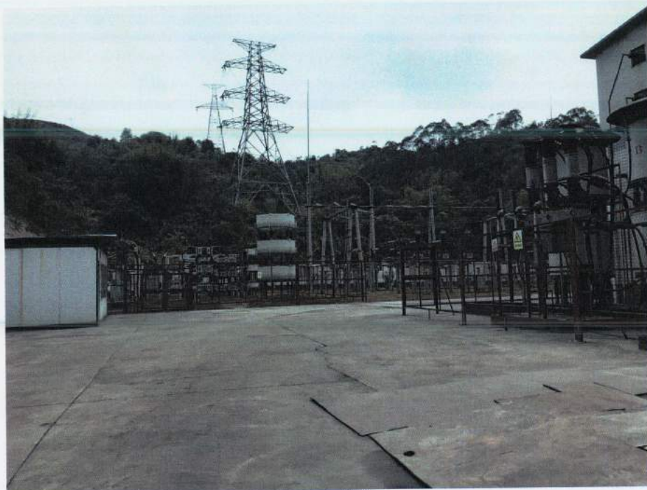
图 8-1 项目试运行期间地面硬底化和植被恢复措施
