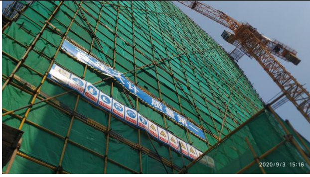
项目施工期围蔽图片 1
