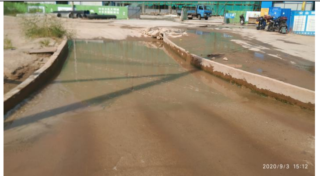
项目施工期汽车出入洗车槽
