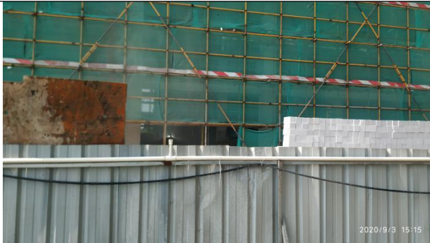
项目施工期围蔽图片 3
