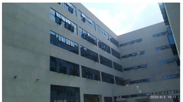
项目 2#厂房图片 2
