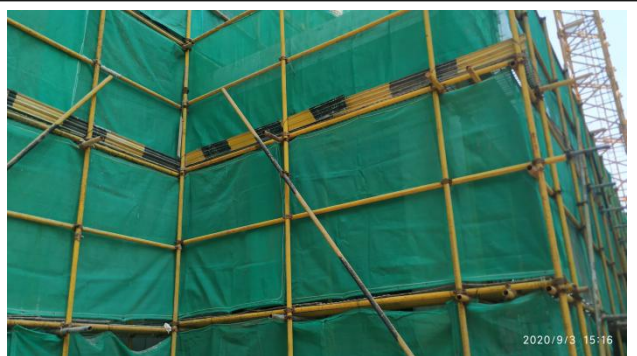
项目施工期围蔽图片 2
